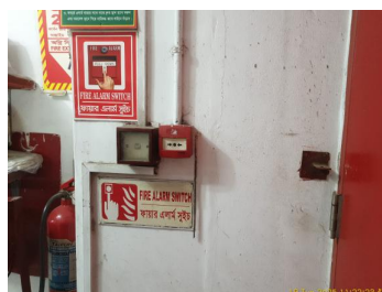
Fire Alarm Switch.jpg
